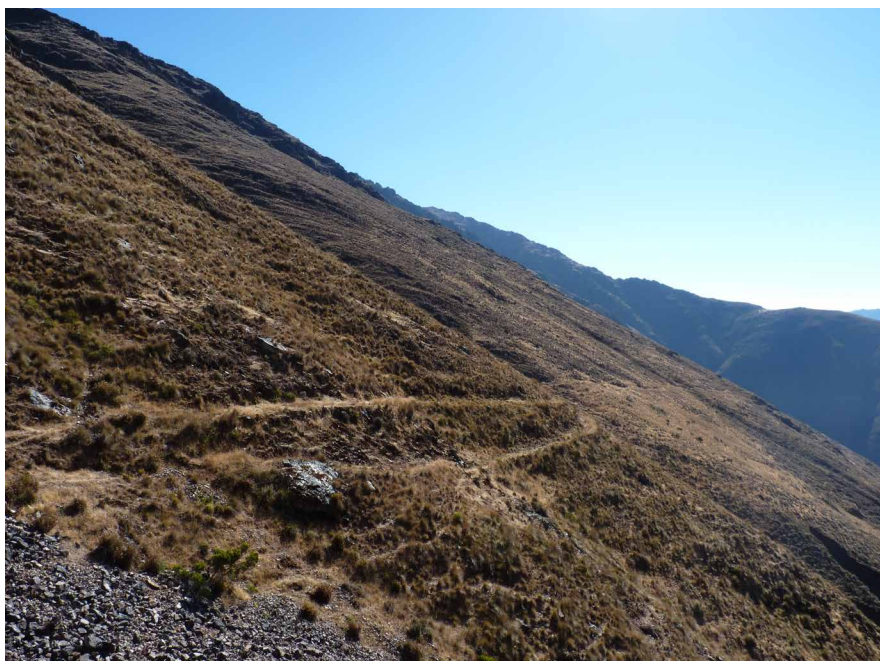
Foto 19. El camino a veces se presenta de esta forma, aparentemente compuesta de dos plataformas o calzadas. Es probable que el muro de sostenimiento inferior haya sido construido para estabilizar el camino principal o quizás haya sido utilizado como descanso
