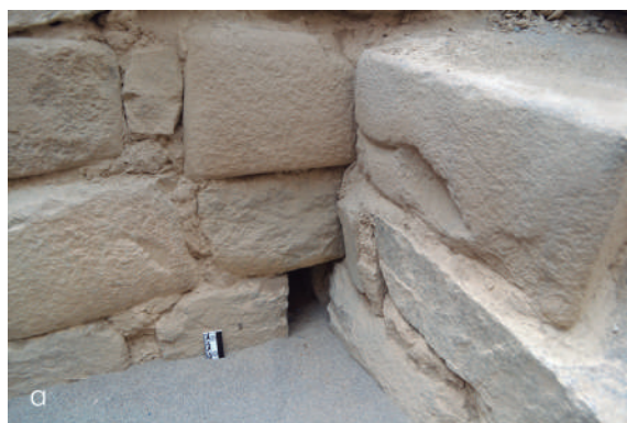
Foto 14. Baño construido con mampostería mixta en Tambo Colorado, incluye bloques almohadillados y biselados (foto por Joseph Bernabé Romero)
