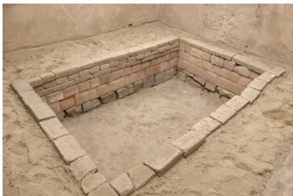
Foto 5. Estanco revestido de mampostería estilo cusqueño (foto por Julissa Ugarte Garay)
