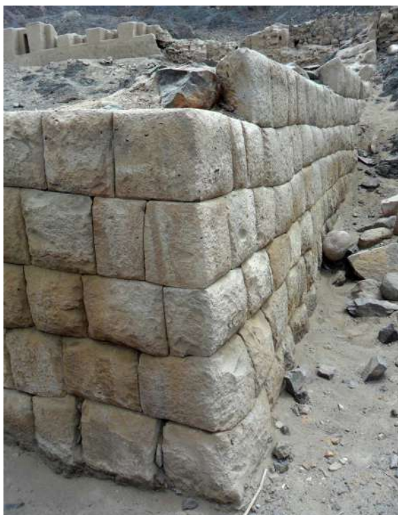
Foto 17. Aparejos del tipo sedimentario y perfil almohadillado en Paredones de Nasca (foto por Joseph Bernabé Romero)
