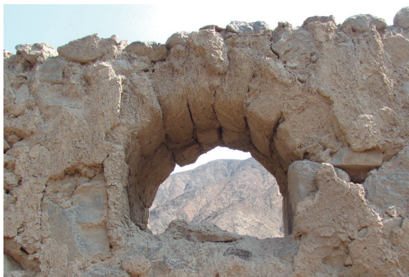
Fotos 2 y 3. Ventana con arco de medio punto (izquierda) y soporte de escalera con arco angular (derecha). Ambos elementos arquitectónicos fueron construidos en base a adobes
