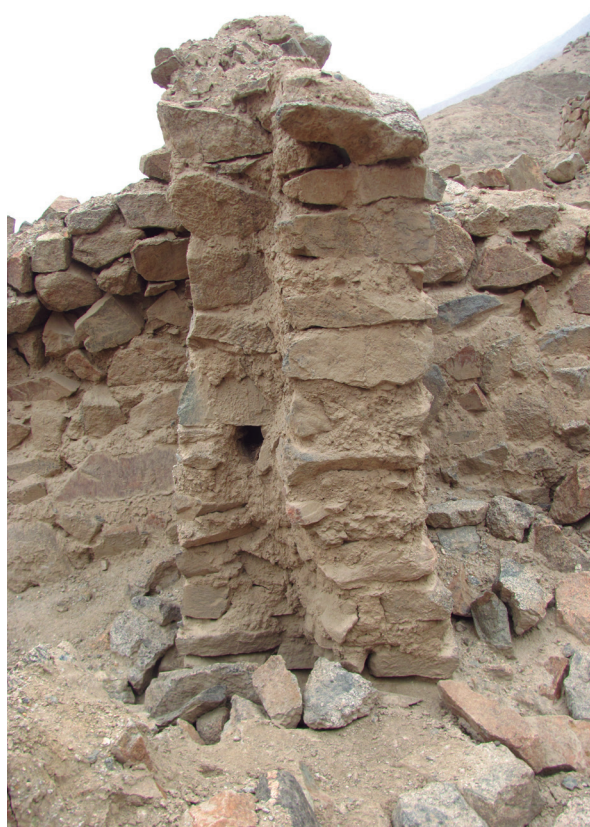
Foto 1. Vano de doble jamba
