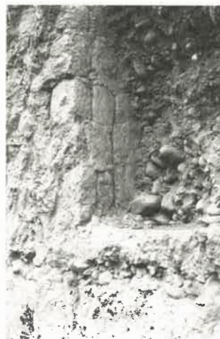
Figura 9: detalle del muro de adobitos cuadrangulares, asociados al piso del interior del recinto. Bajo este se observan los cimientos (foto: Rafael Valdez, 2002).
