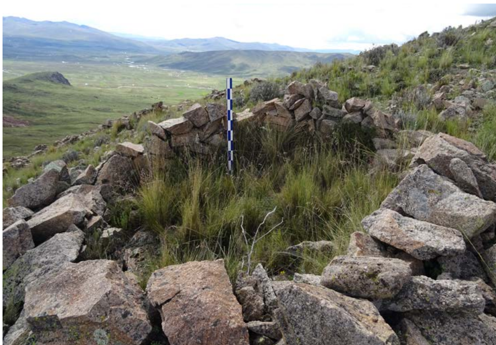
Figura 12. Estructura circular doméstica del Pukara Quinturani construido en seco.
